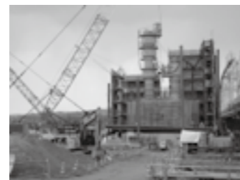
遮断壁(鋼矢板)の事前施工状況▶ P.13
