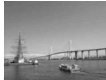
臨港道路富山新港東西線(新湊大橋)の全景▶ P. 3
